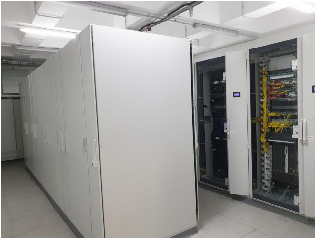
Data Center TUIASI
